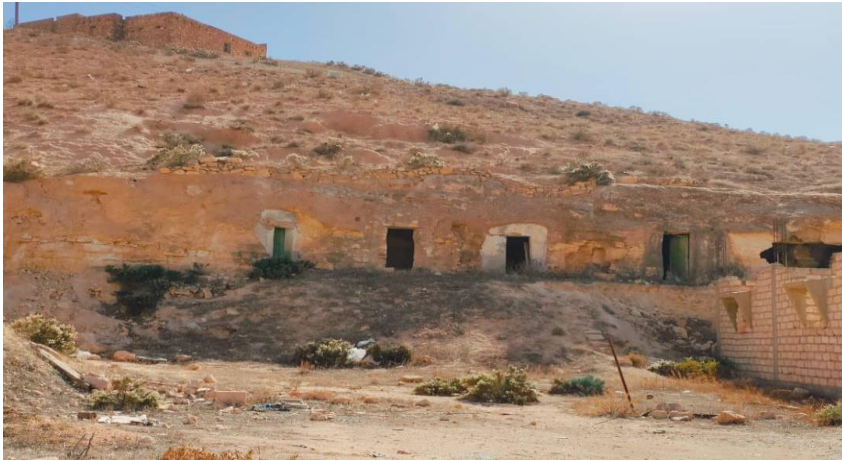
صورة (5) دواميس فردية مبطنة بالمونة غير الاسمنتية تم صيانتها من الخارج بمونة اسمنتية.
