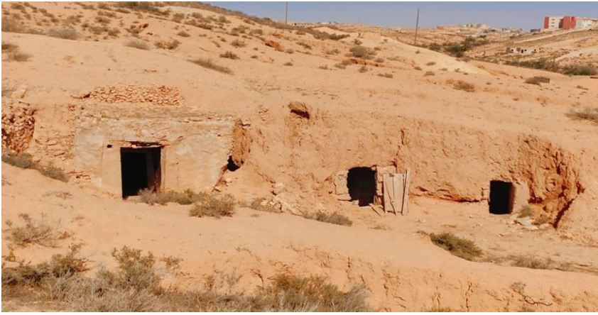
صورة (4) دواميس فردية مبطنة بالمونة غير الاسمنتية.
