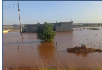
صورة (5) غرق المنازل بسهل المرج
